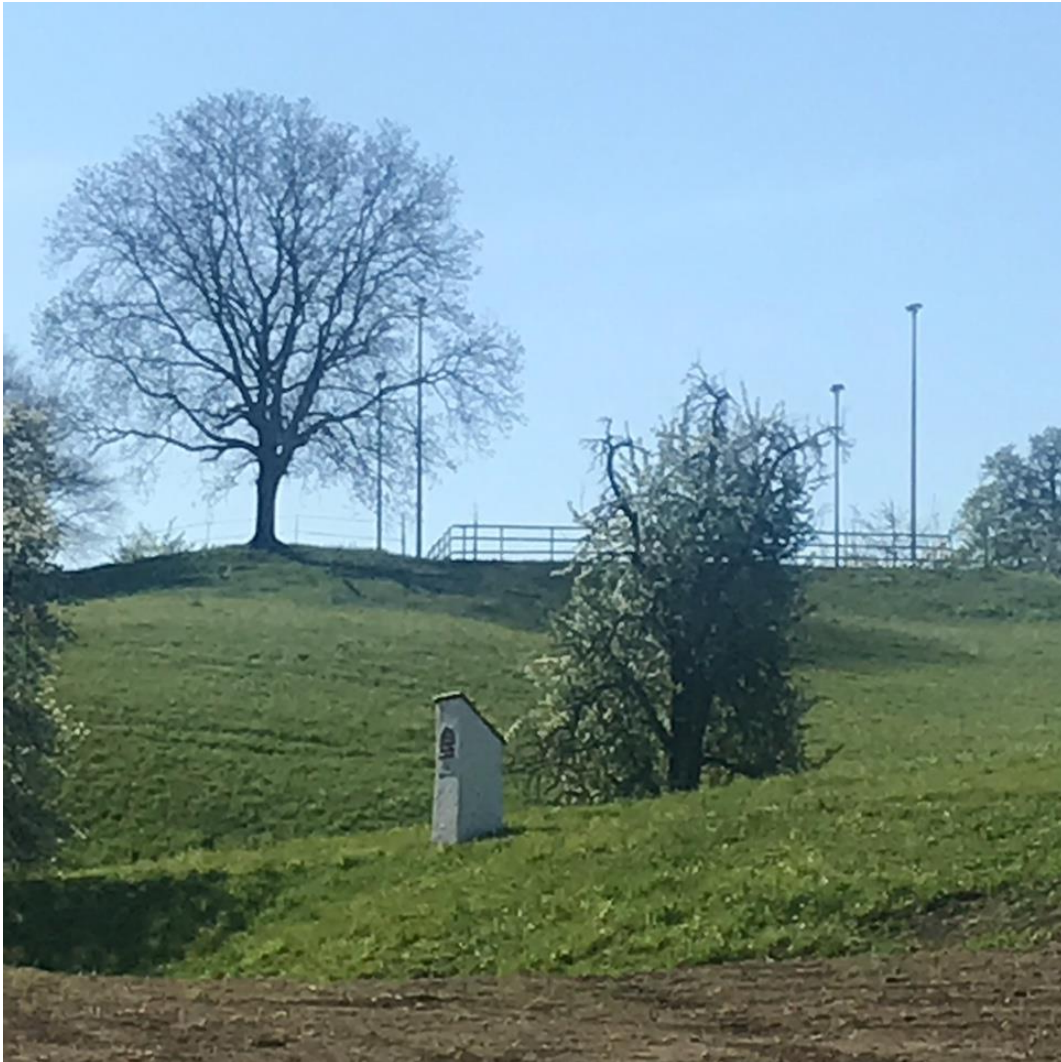
Abb. 1: Reitplatz mit Beleuchtungsanlage
