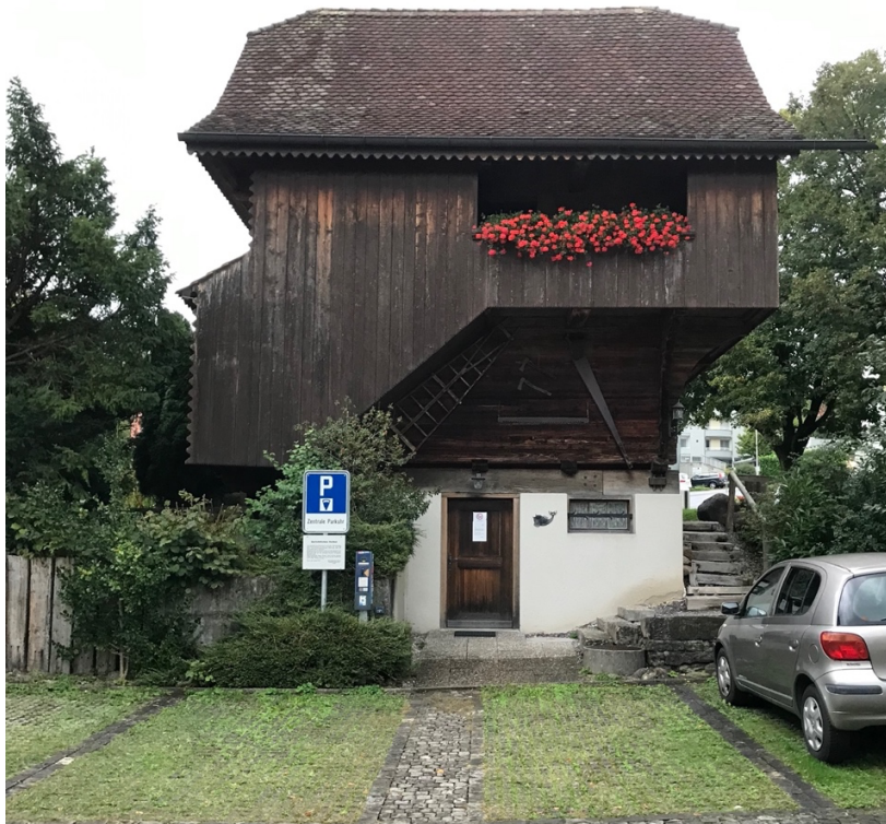
Abb.2: Sichtbarer Bereich des Untergeschosses an der Neumattstrasse
